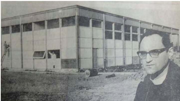
Pastoor Schoenmakers voor de in aanbouw zijnde Markuskerk
